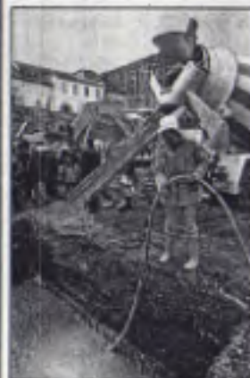
Gegen Mittag floß der erste Beton für das Kino-Fundament. Foto: Olm
