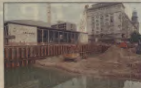
Vor dem „Kosmos“ (Karl-Marx-Allee) wurden bereits Gruben für die Tiefgarage ausgehoben. Fotos: Kroh
