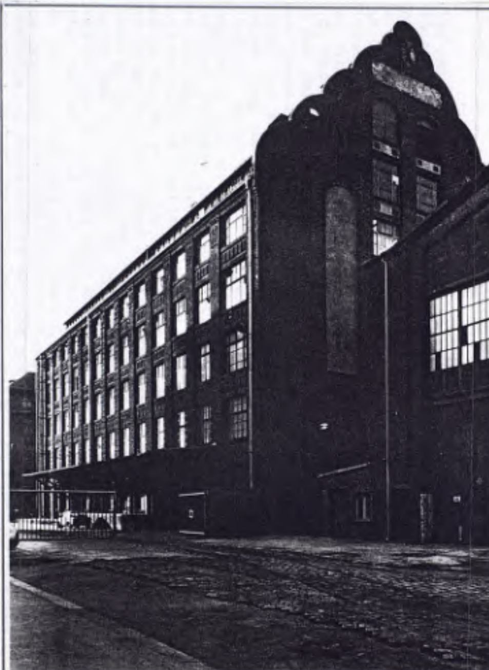
Die 108-Ehrenbergstraße 17-18 „Deutsche Gasglühlicht AG“, Nordturm und Ostturm des Gebäudes III, 1906-07 von Theodor Scharoun
