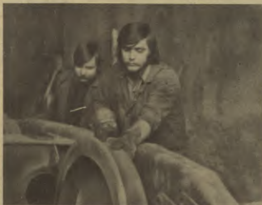
Kollegen der M 218 bei der Aufarbeitung von Drehgestellen
