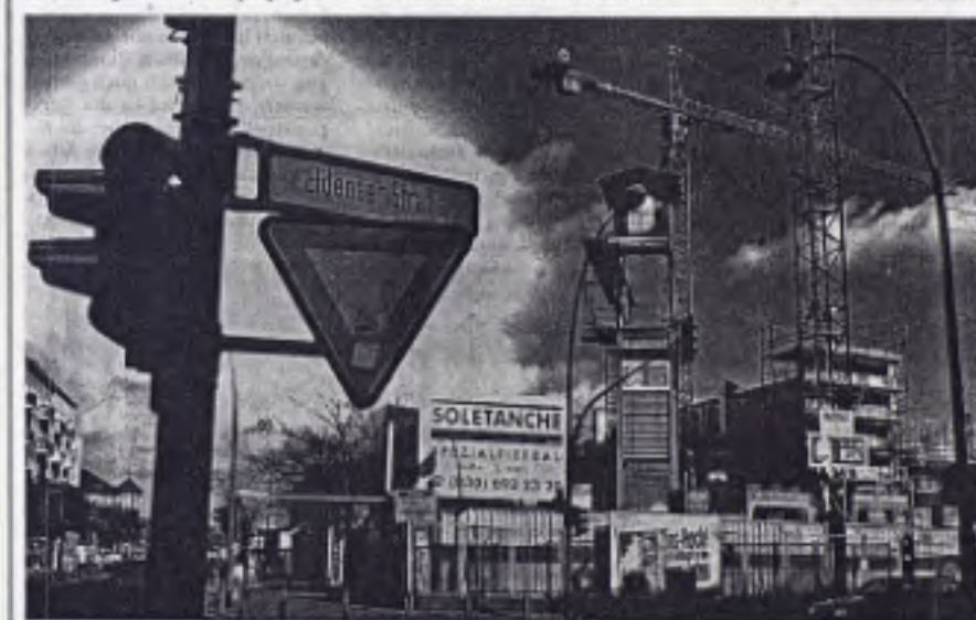
Platz der Bauhütte an der Eldener Straße?
