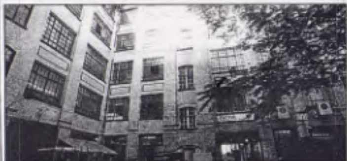
Eine alte Fabrik soll nach vollständiger Sanierung zur Werkstatt für Behinderte werden.
