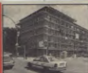
An der Landsberger Allee (Friedrichshain) wird ein Altbau zum Ärztehaus umgebaut.
