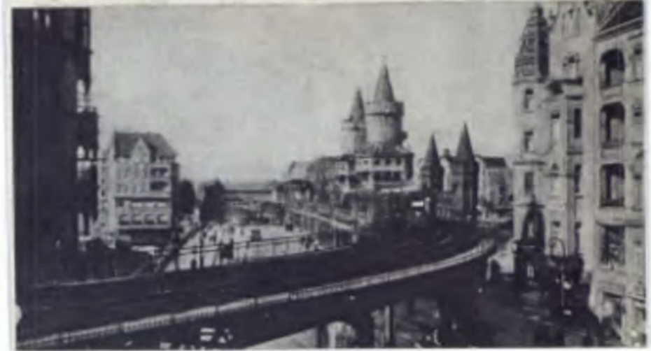
Hochbahnhof Osthafen mit Blick auf die Oberbaumbrücke
